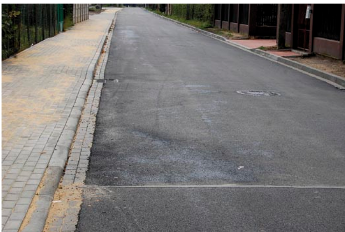
◀ Nawierzchnia przy ul. Konopnickiej
