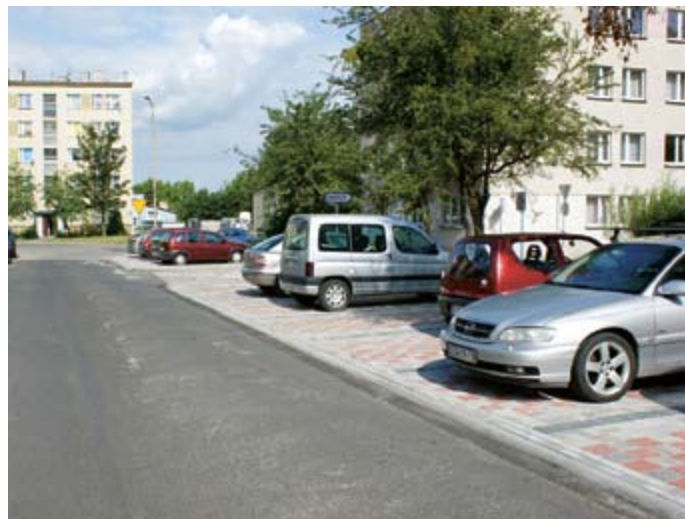
...i po przebudowie.
