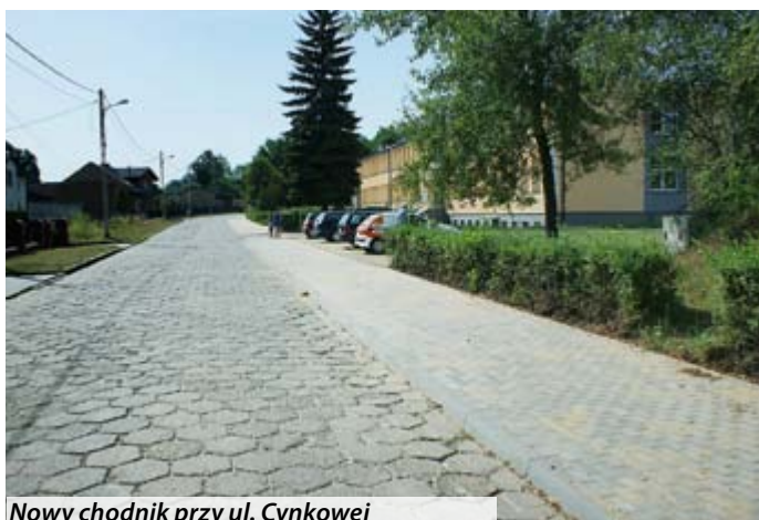
Nowy chodnik przy ul. Cynkowej
