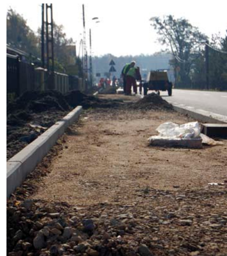
▲ Budowa chodnika w ciągu drogi wojewódzkiej nr 912 w Żyglinku
