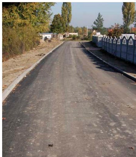
▲ Przebudowa ulicy Rolnej - Południowej w Żyglinie
