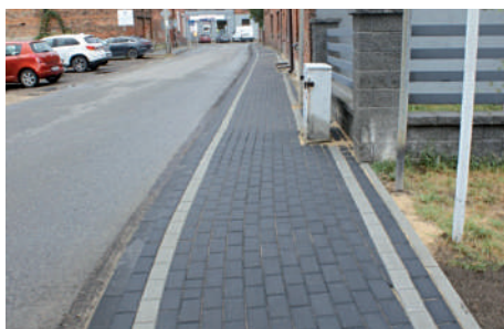
Ul. Rubinowa – nowy chodnik od DW 908 do skrzyżowania z ul. Dębina (przy współudziale finansowym gminy)
