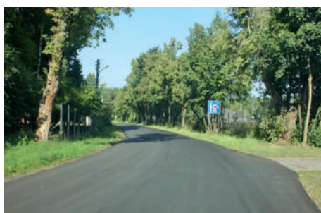
Ul. Dworcowa – nowa nakładka asfaltowa od posesji nr 111 do skrzyżowania z ul. Leśną
