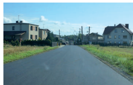
Ul. Borowa w Brynicy – częściowe wymiany nakładek asfaltowych
